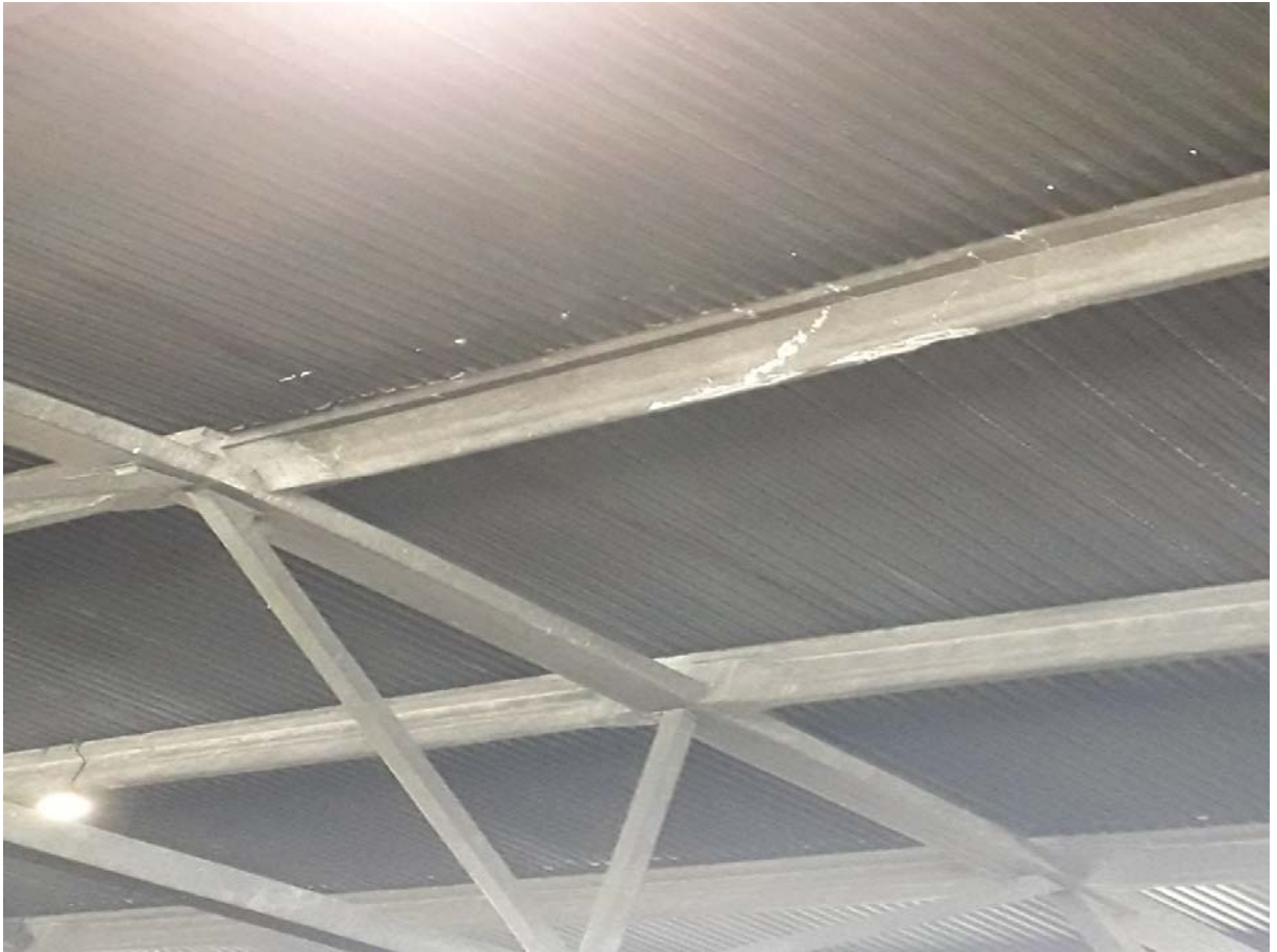
Fotografija 5: Rožnjača u osovini C – torniranje i izlazak iz ležišta, lom kroz sredine nosača
