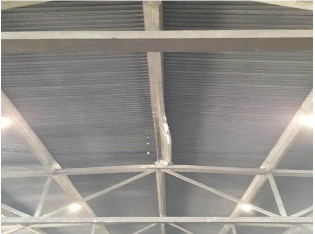
Fotografija 7: Rožnjača u osovini C – torniranje i izlazak iz ležišta, lom kroz sredine nosača
